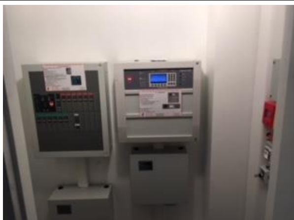
Nouveau local SSI positionné à l'entrée du bâtiment
